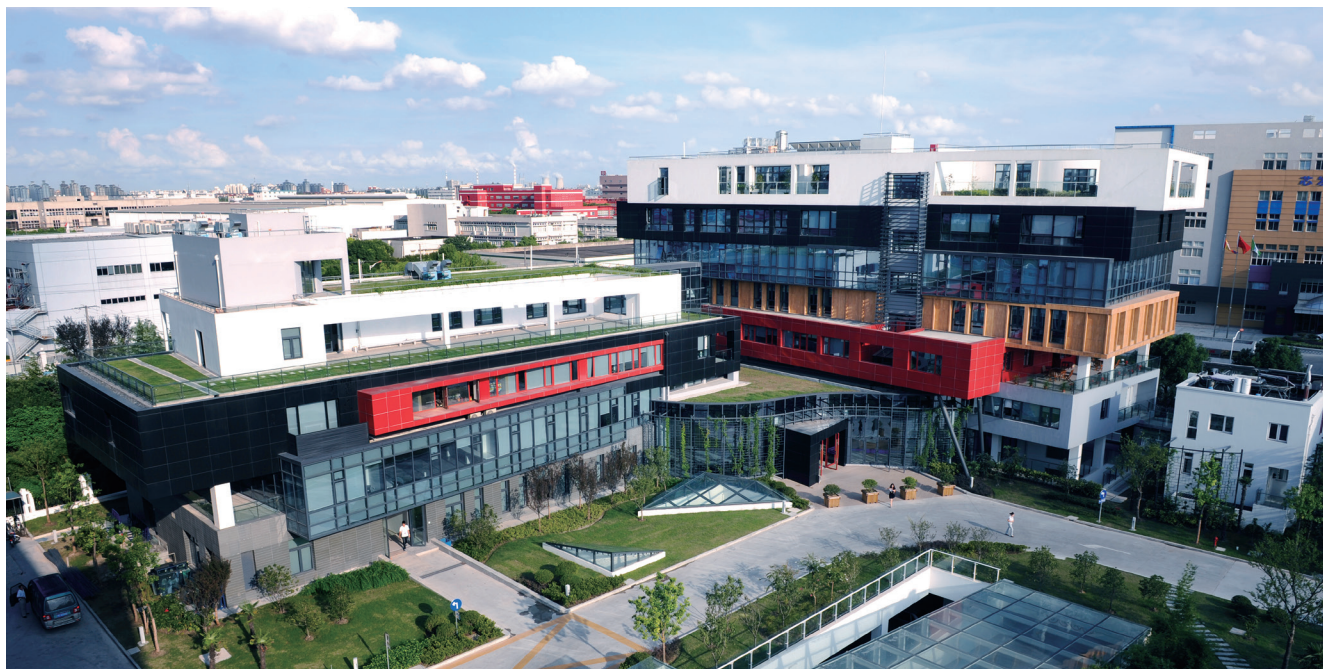
上海建科集团 莘庄综合楼
