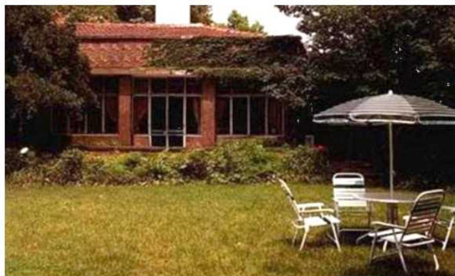
(a) 1号楼南立面原状
