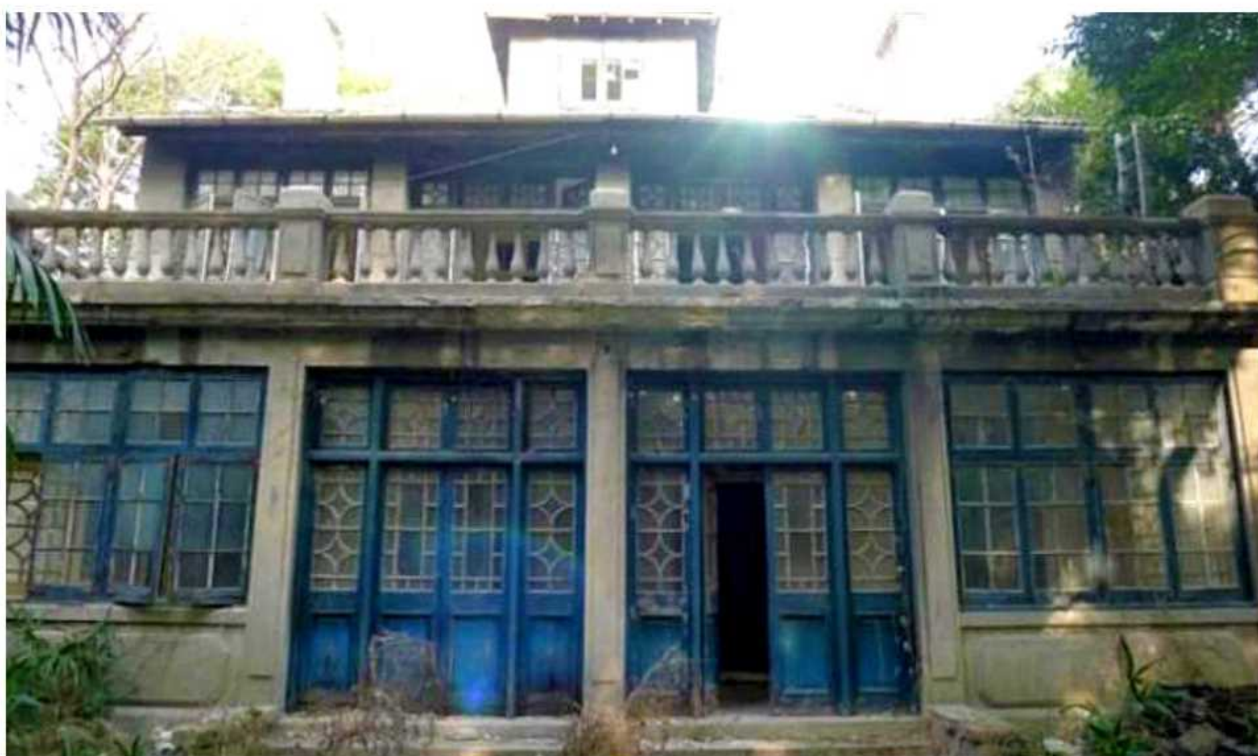
(a) 2 号楼南立面原状
