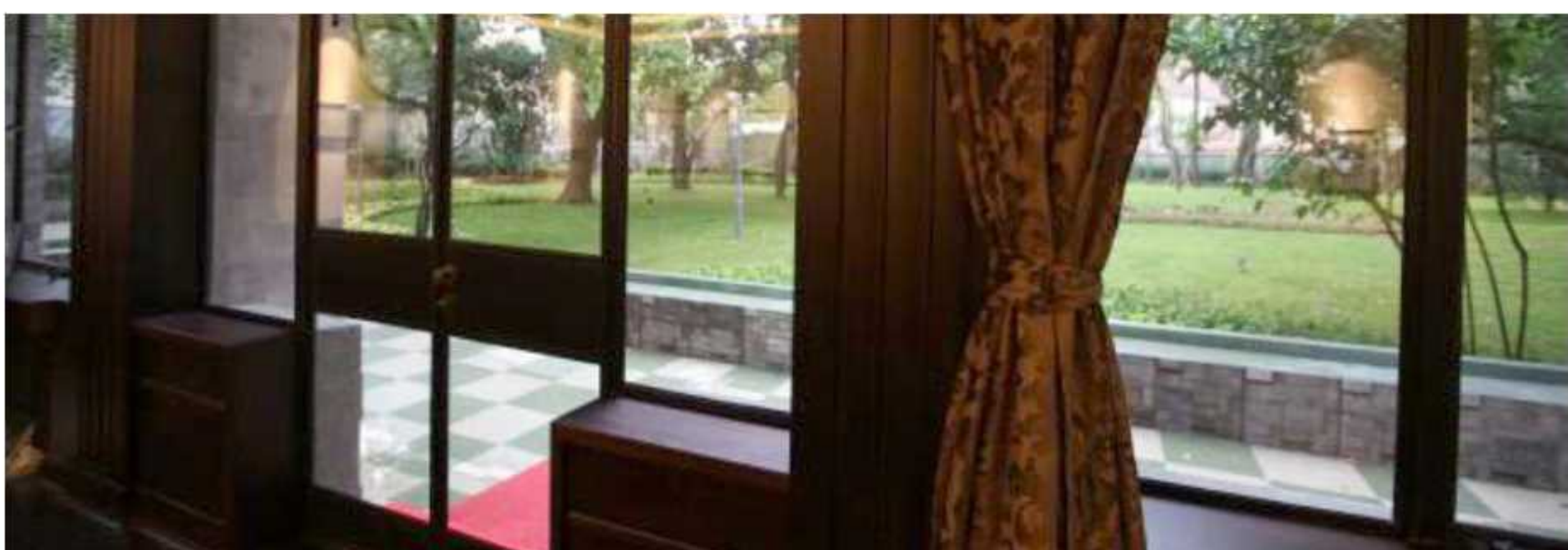
图5 1号楼南立面金属门窗修缮前后对比
