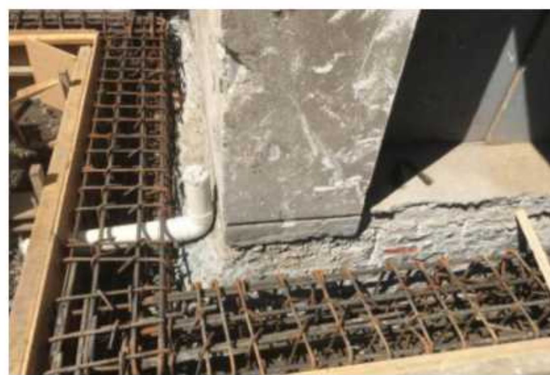
图 3 基础加固
