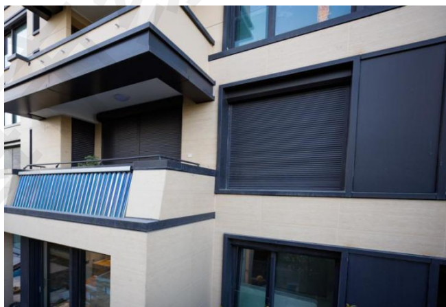
图 4.21 项目太阳能热水及可调节外遮阳实景图
