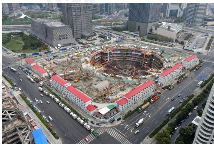
图 4.18 上海中心大厦底板一次浇筑现场图
