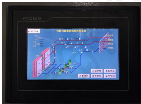
图 5.37 冬季供水换热机组变频改造
