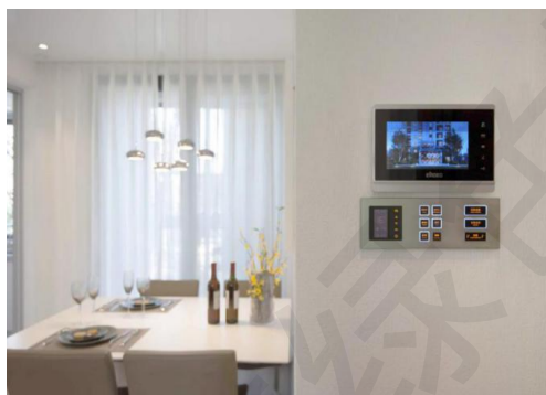
图 4.24 项目智能家居中控实景图
