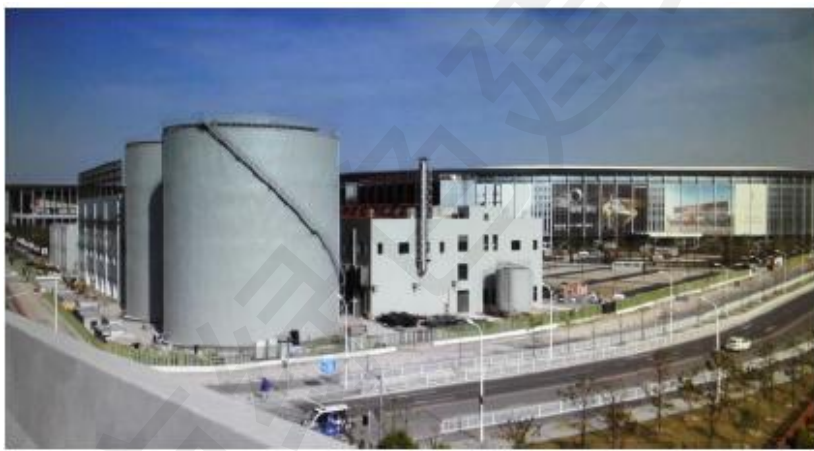
图 4.9 中国博览会会展综合体项目（北块）分布式能源中心机房
