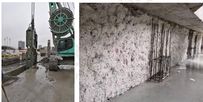
图 5.13 两墙合一地下连续墙施工技术
