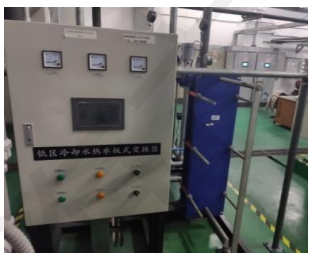
图 5.43 建筑冷凝热回收
