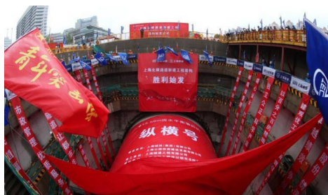
图 5.15 北横通道工程施工现场
