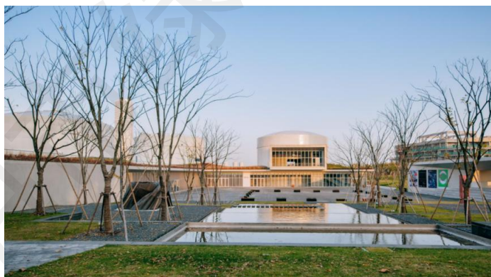
图 5.56 海绵城市景观工程实景图
